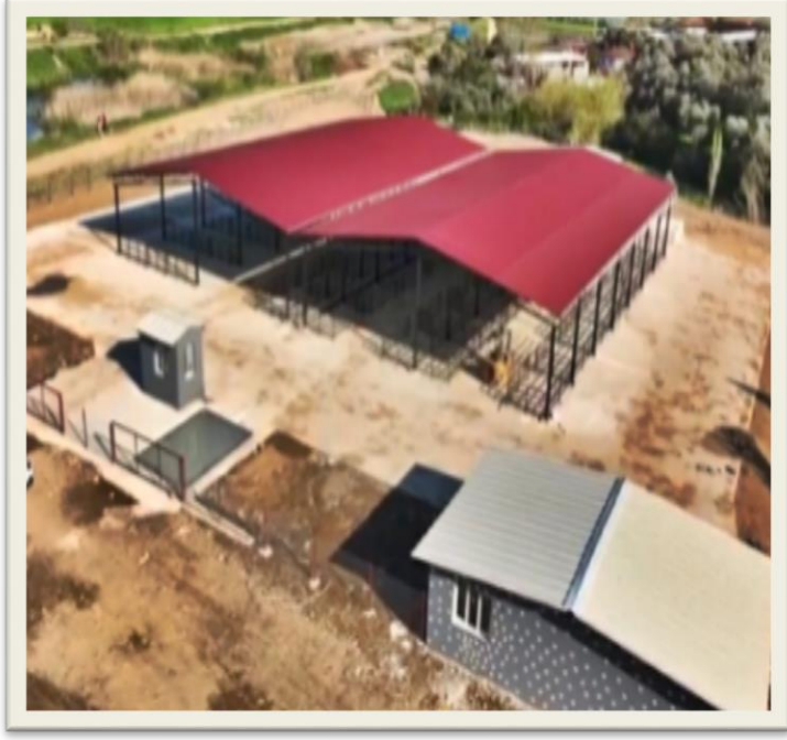
Mehmet TÜRKEKUL Gırlı Hayvan Satış ve Kesim Yeri 1240 m2 çelik konstrüksiyon hayvan pazarı yapım işi tamamlanmıştır.
